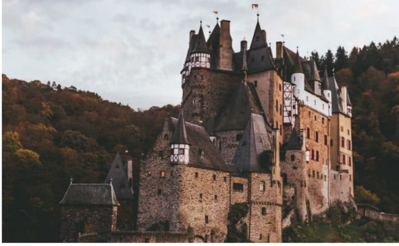
Denkmalpflege mit Drohnen: Technik zur Instandhaltung nutzen. (Foto: Leonard von Bibra)
